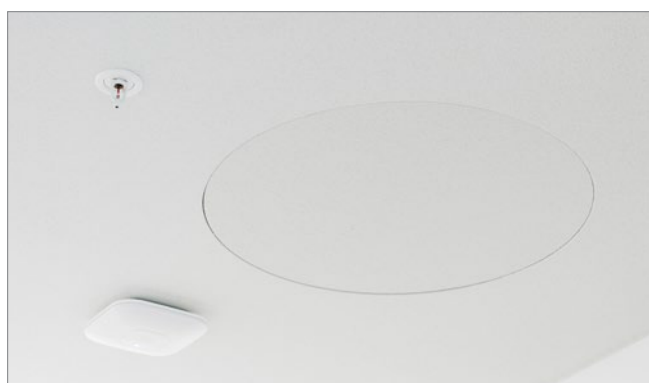
Openen van het luik. Til het volledige toegangsluik 1 cm op en draai het. Het toegangspaneel opent naar beneden.
